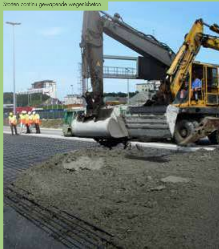
Storten continu gewapende wegenisbeton.
