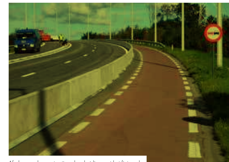
Afschermende constructies als scheiding met het fietspad.
