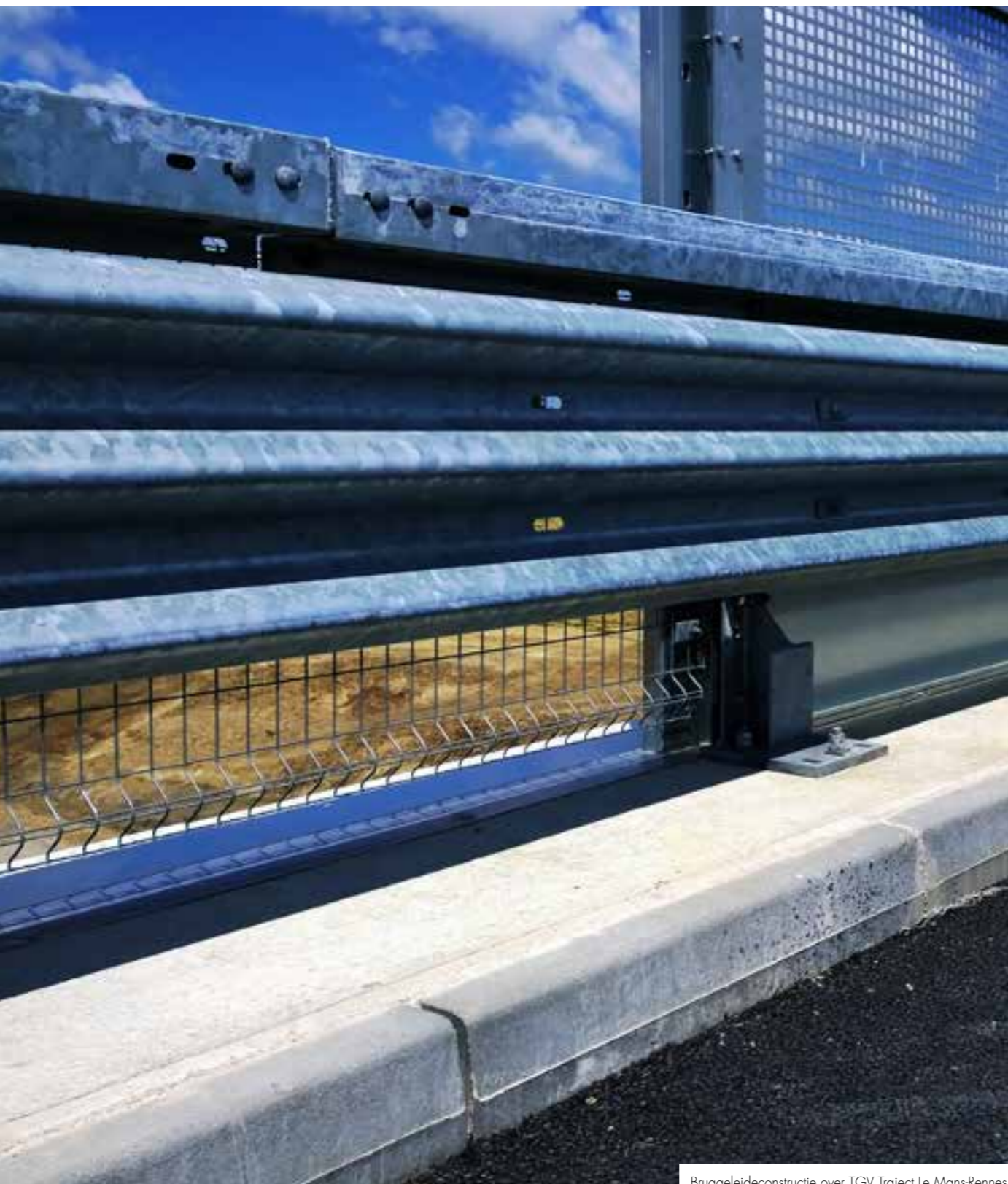
Bruggeleideconstructie over TGV Traject Le Mans-Rennes.
