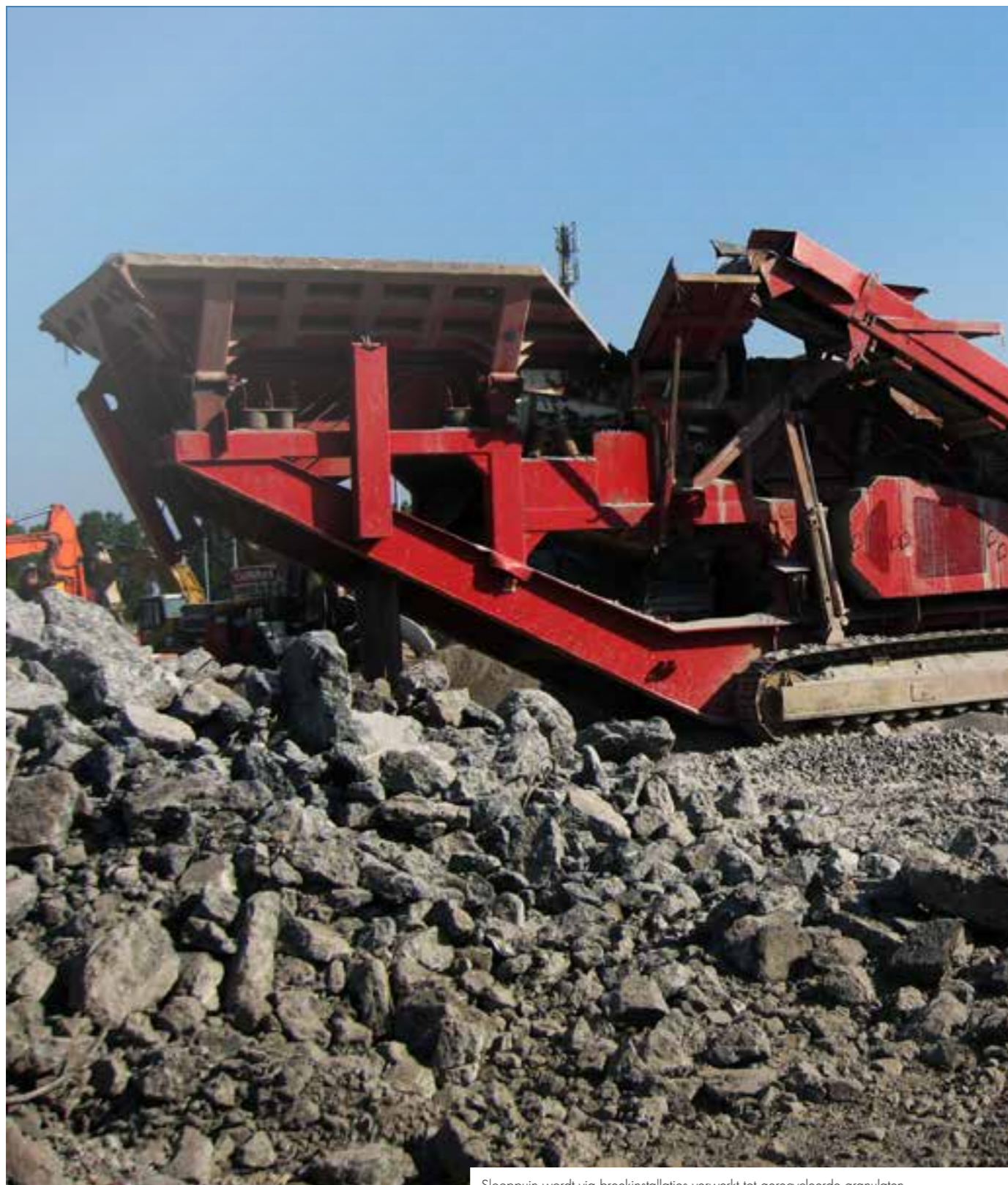
Slooppuin wordt via breekinstallaties verwerkt tot gerecycleerde granulaten.
