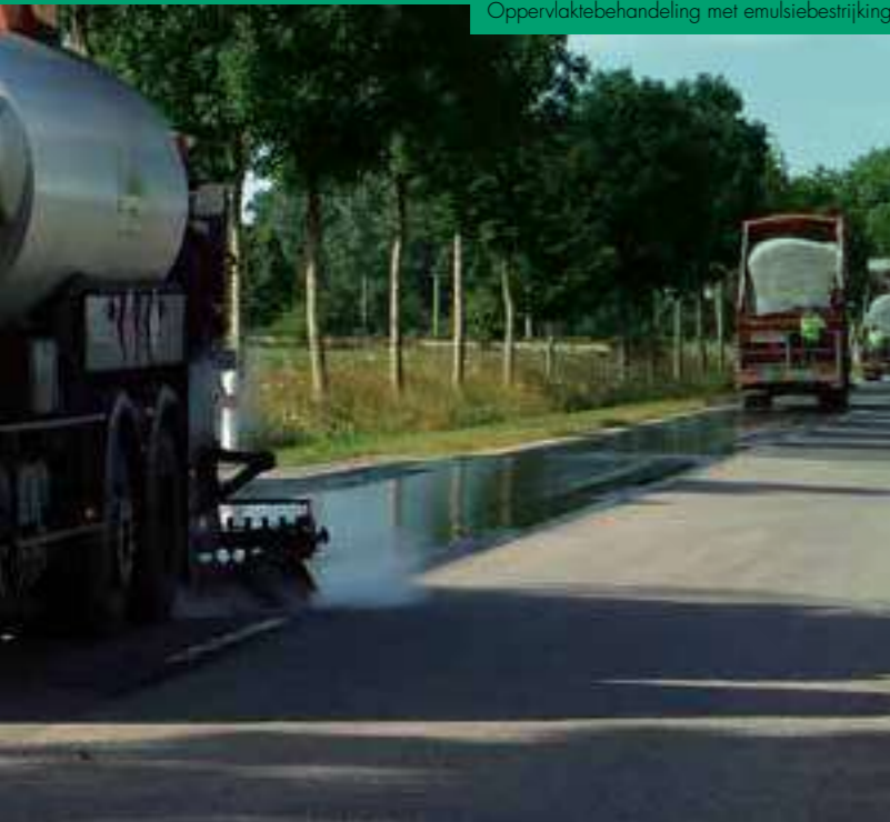
Oppervlaktebehandeling met emulsiebestrijking.
