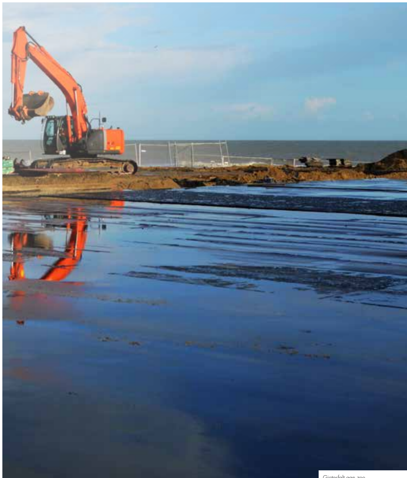
Gietasfalt aan zee.
